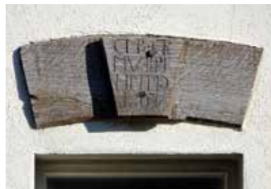
Rest des Scheunenbogens
